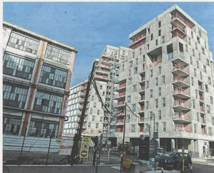
La Zac des Girondins est en train de sortir de terre à Gerland. Six mille habitants y sont attendus d'ici à 2027, et les premiers commerces y ouvriront en 2020.
